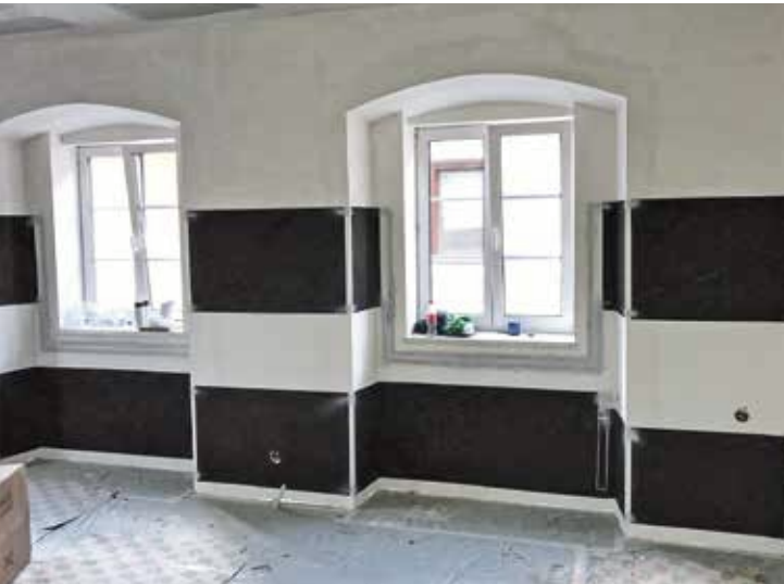
Die Flächendirektheizung auf 24 Volt Niederspannung besteht aus elektrisch leitfähigen Elementen, die auf Wänden, Decken und Böden einsetzbar sind.
